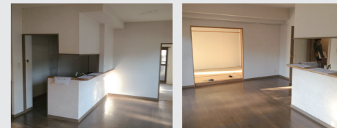
6階建てマンションの1階、東南角部屋にあるT様邸。南に面してワイドスパンで、窓の外には隣接する公園が眺められる。環境のいい物件です。リノベーションによりT様の暮らしに合った間取りやデザインに生まれ変わりました。
